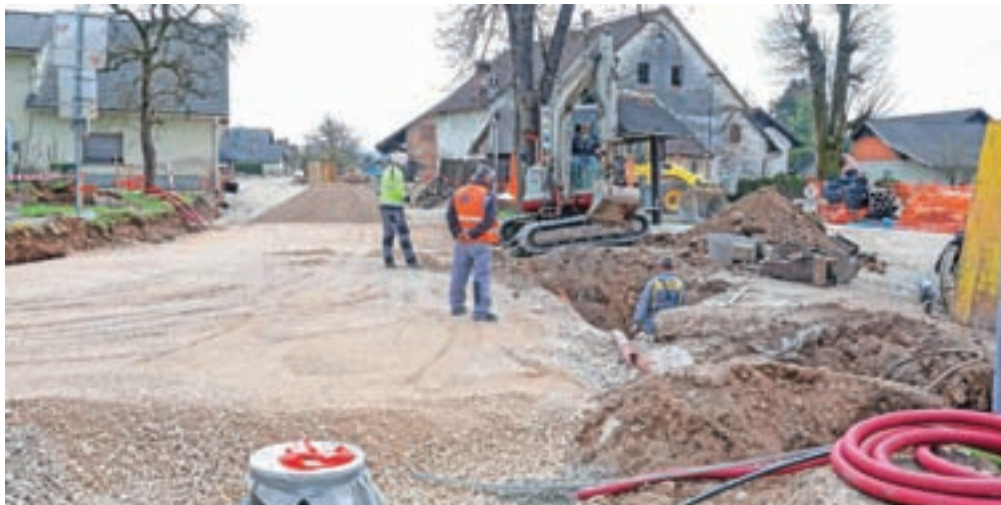
Gradnja kanalizacije na Prebačevem / FOTO: TINA DOKL
