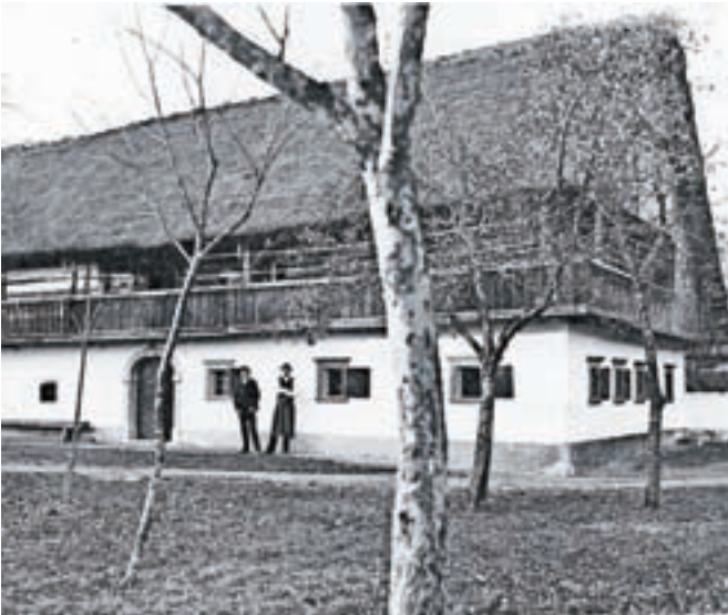
Bankova hiša, zgrajena leta 1740 (z gankom)
